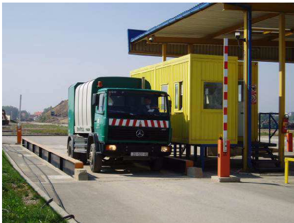
Ugradnja mosta vage MJ100 u plitku i
