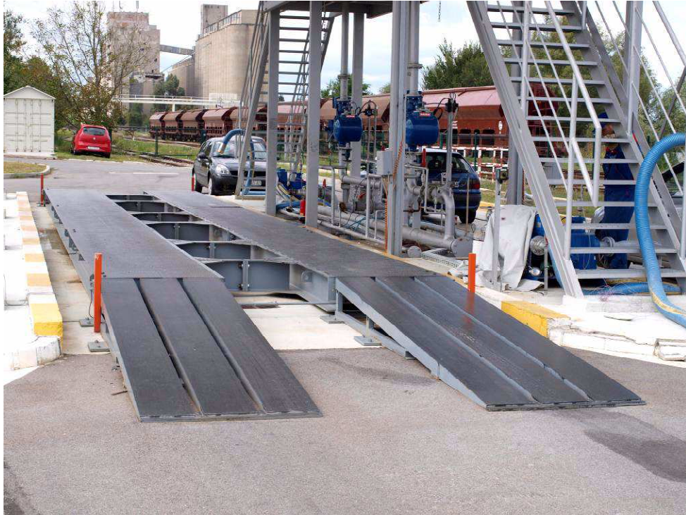
Površinska ugradnja, čelični most, vaga MJ100
